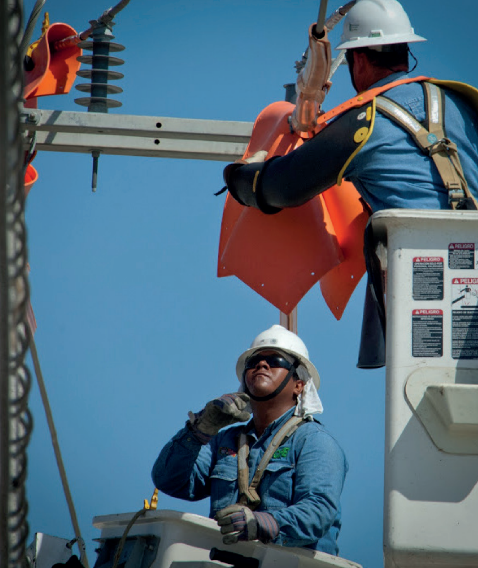
Fotografía 10. Trabajadores en maniobras de restablecimiento de energía eléctrica. Cabo San Lucas, Baja California Sur. CFE.
