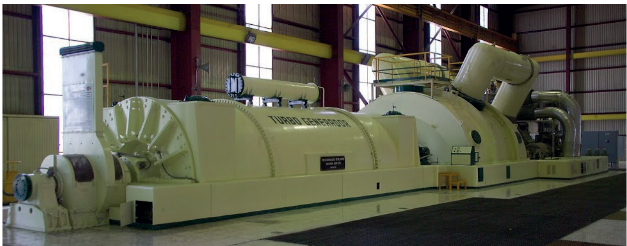
Fotografía 8. Turbogenerador, Central termoeléctrica, "Salamanca". Salamanca, Guanajuato. CFE.
