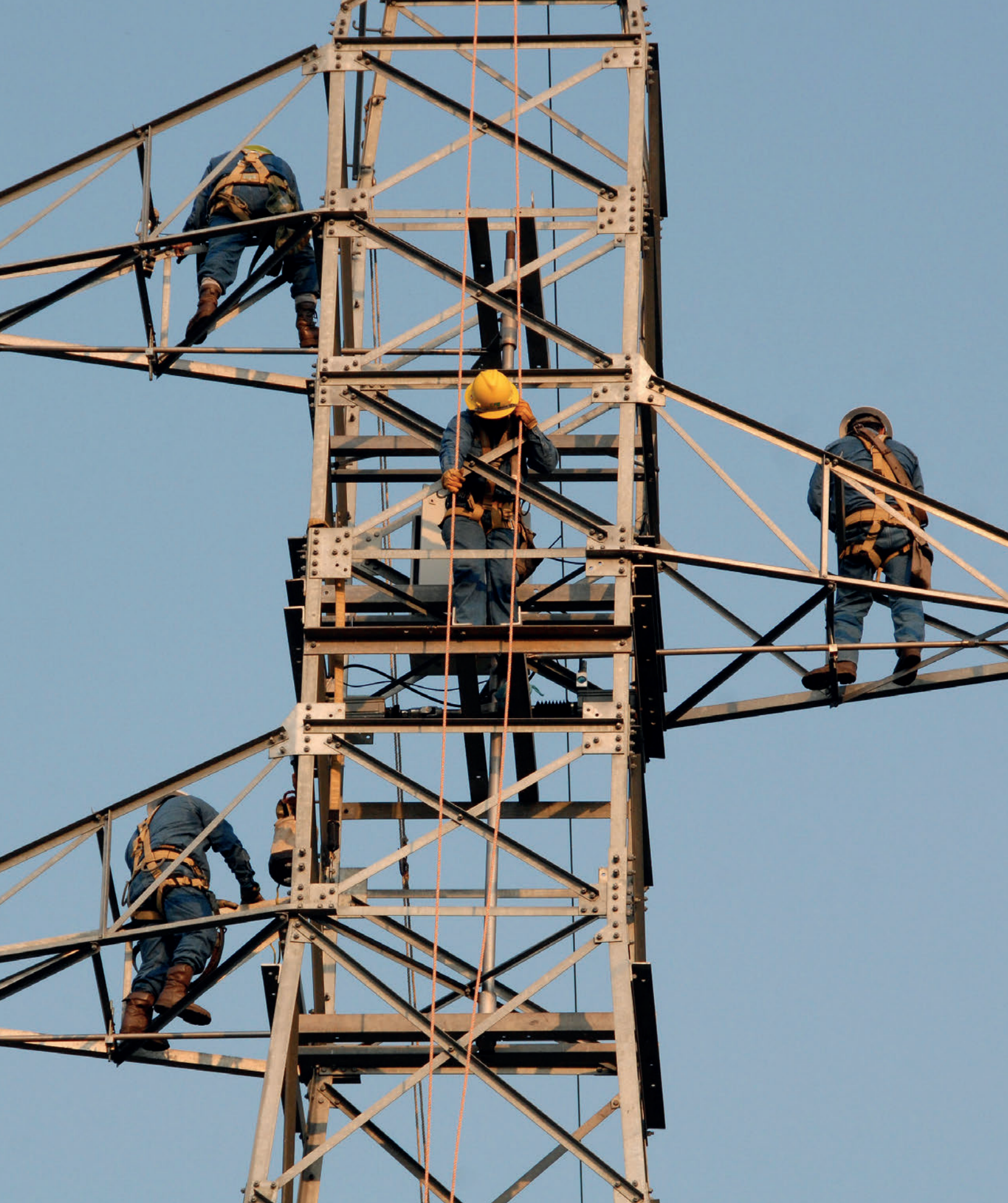
Fotografía 3. Trabajos en torre de transmisión. Acapulco, Guerrero. CFE.
