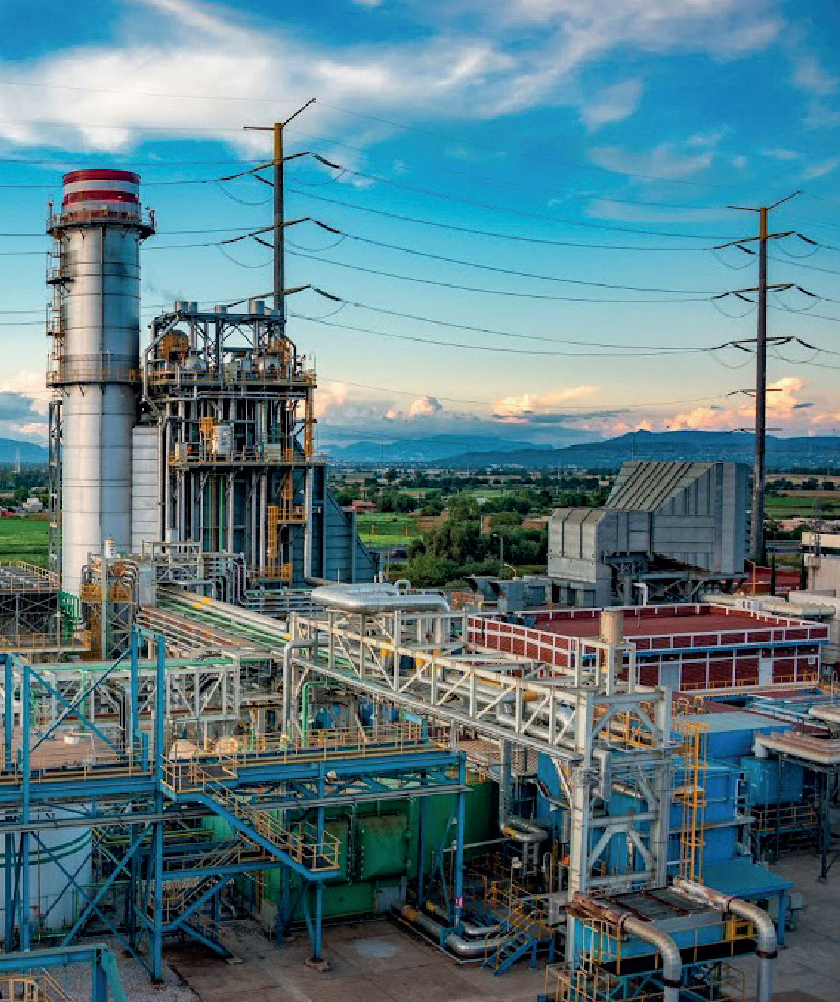
Fotografía 2. Central Ciclo Combinado "Tula". Tula, Hidalgo. 3 de octubre de 2019. CFE.
