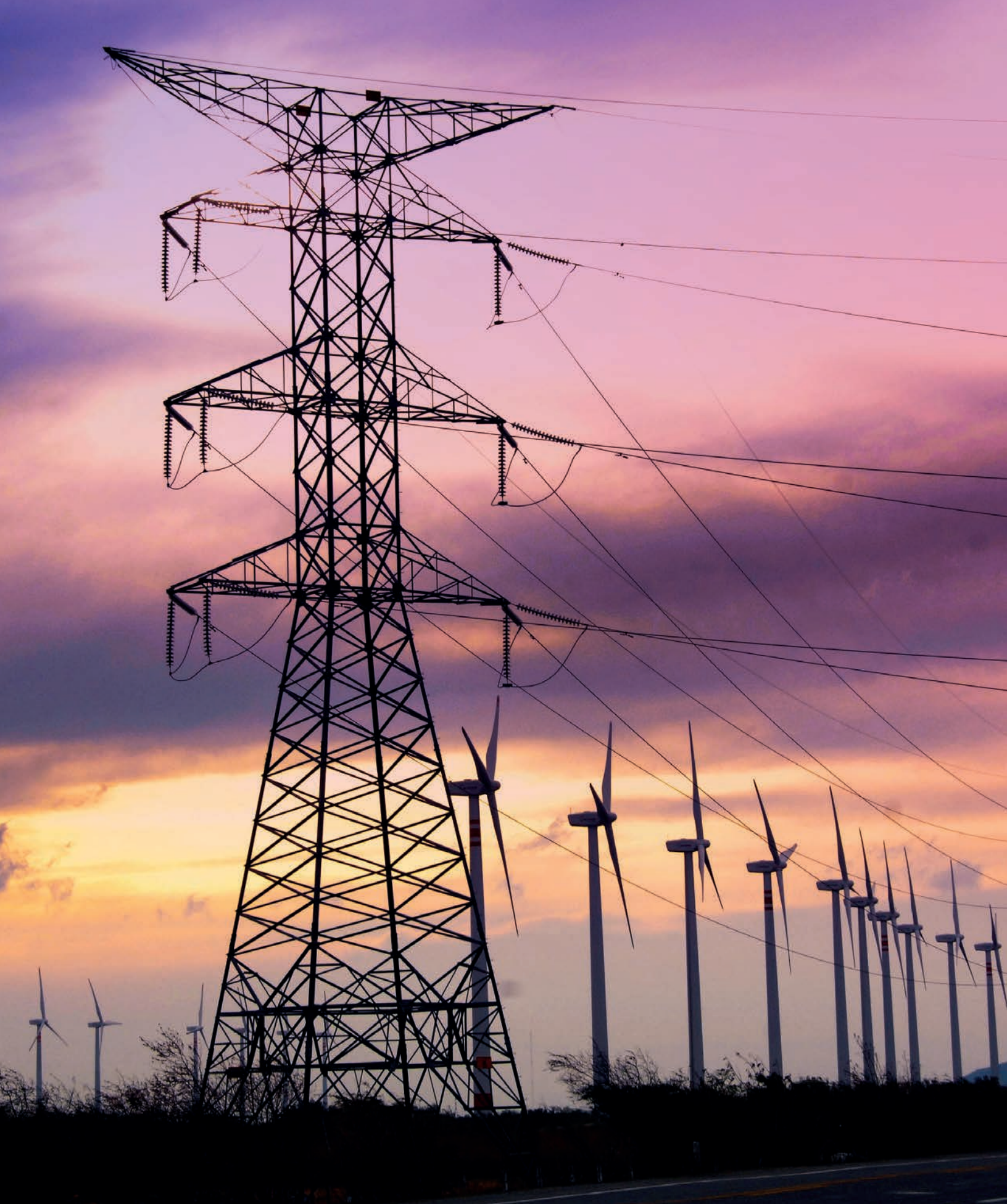
Fotografía 28. Torre de Transmisión. La Venta, Oaxaca. CFE.
