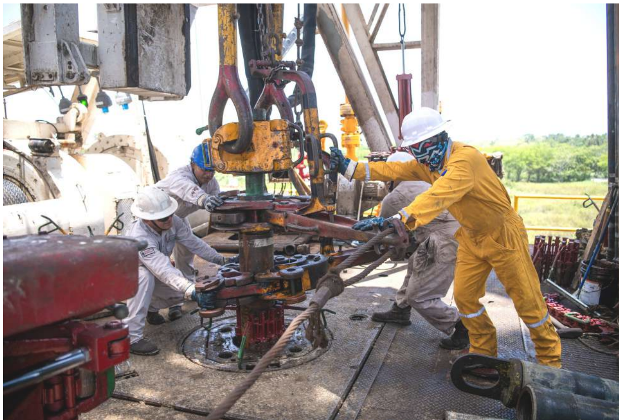
Tupilco 3017, trabajos de perforación.
