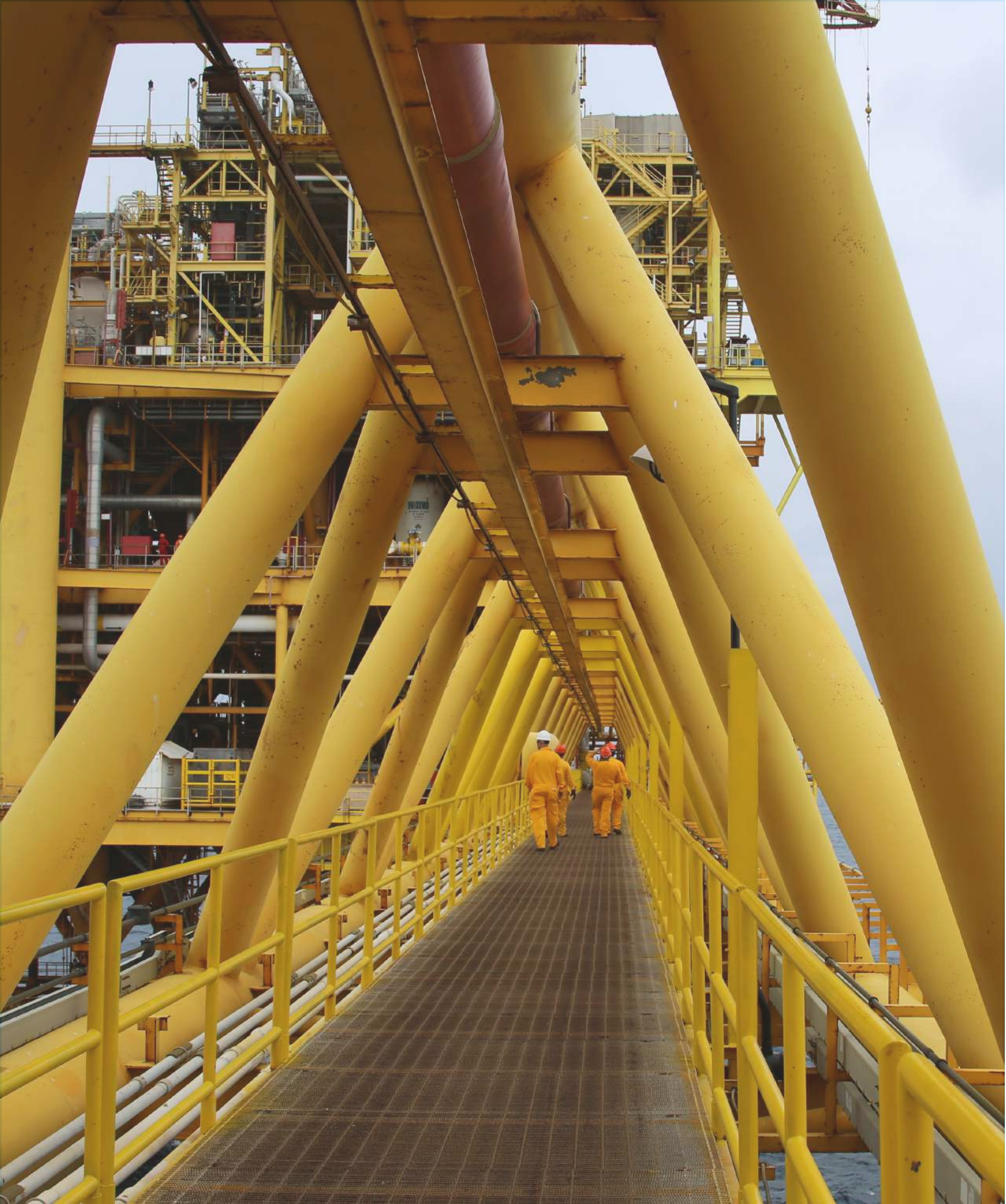
Trabajadores en plataformas de aguas someras. Sonda de Campeche, Campeche.
