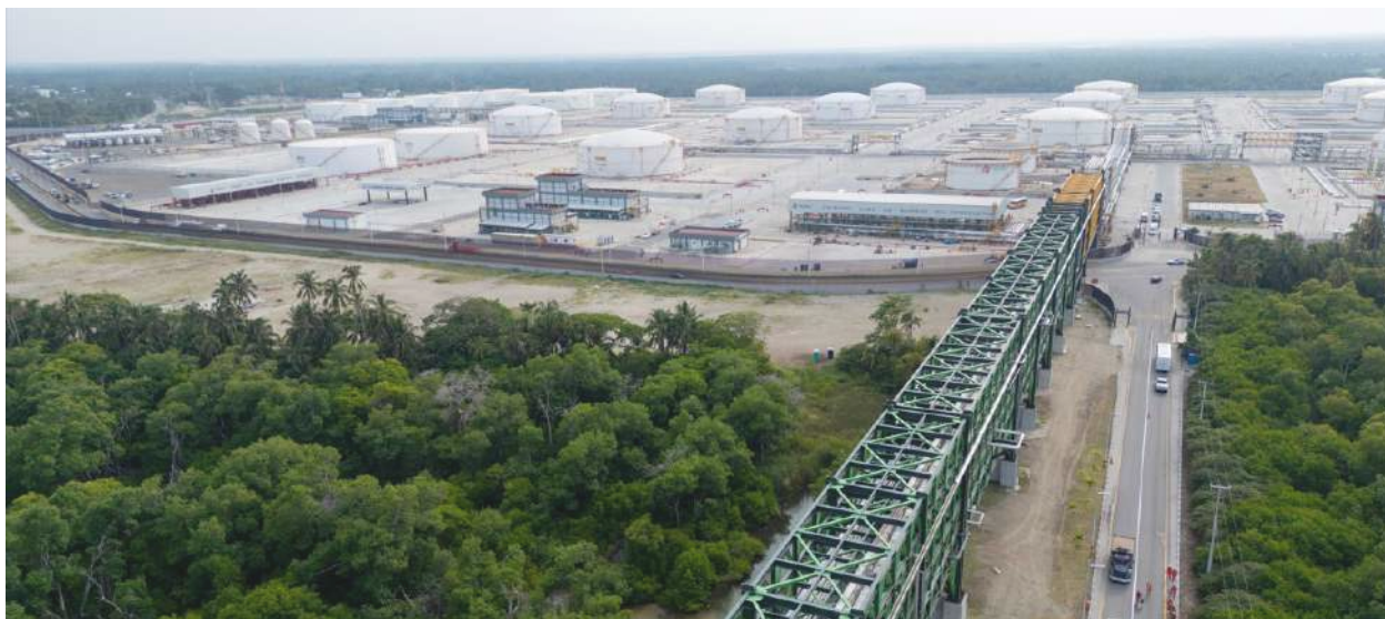
Terminal de almacenamiento y distribución. Refinería Olmea en Dos Bocas, Paraíso, Tabasco.
