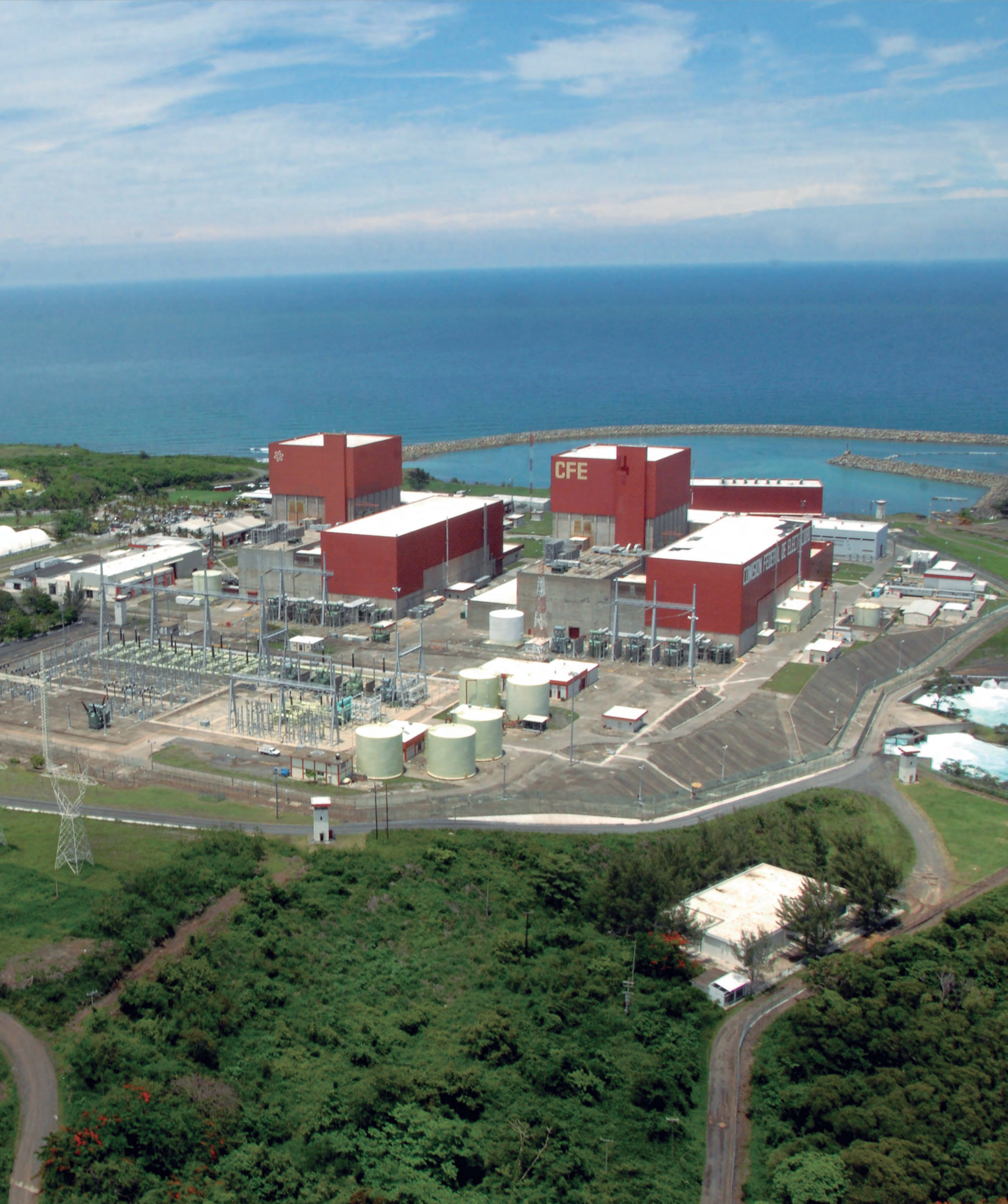
Fotografía 12. Central Nucleoeléctrica Laguna Verde. Comisión Federal de Electricidad.
