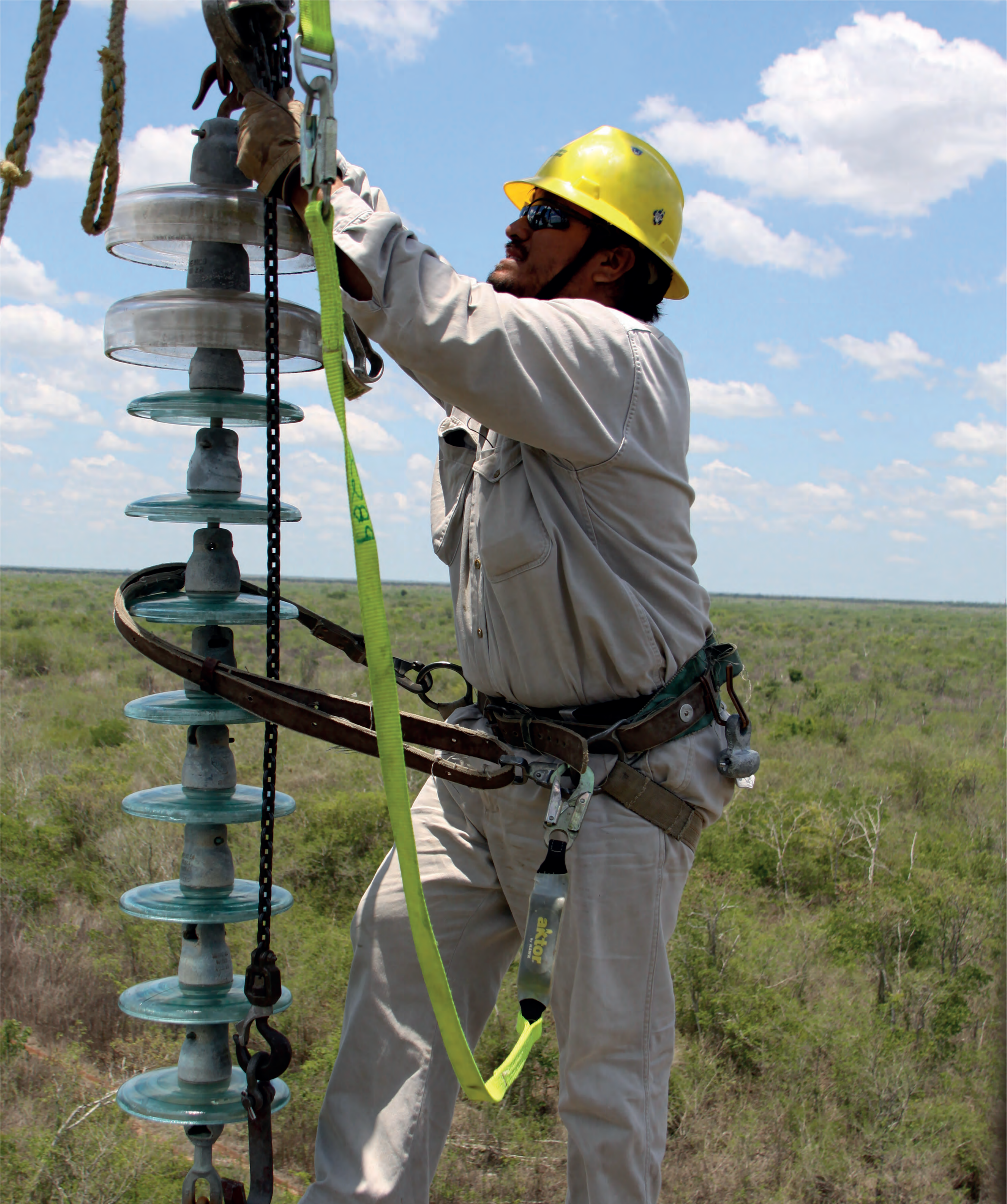
Fotografía 41. Maniobras occidente. Comisión Federal de Electricidad.
