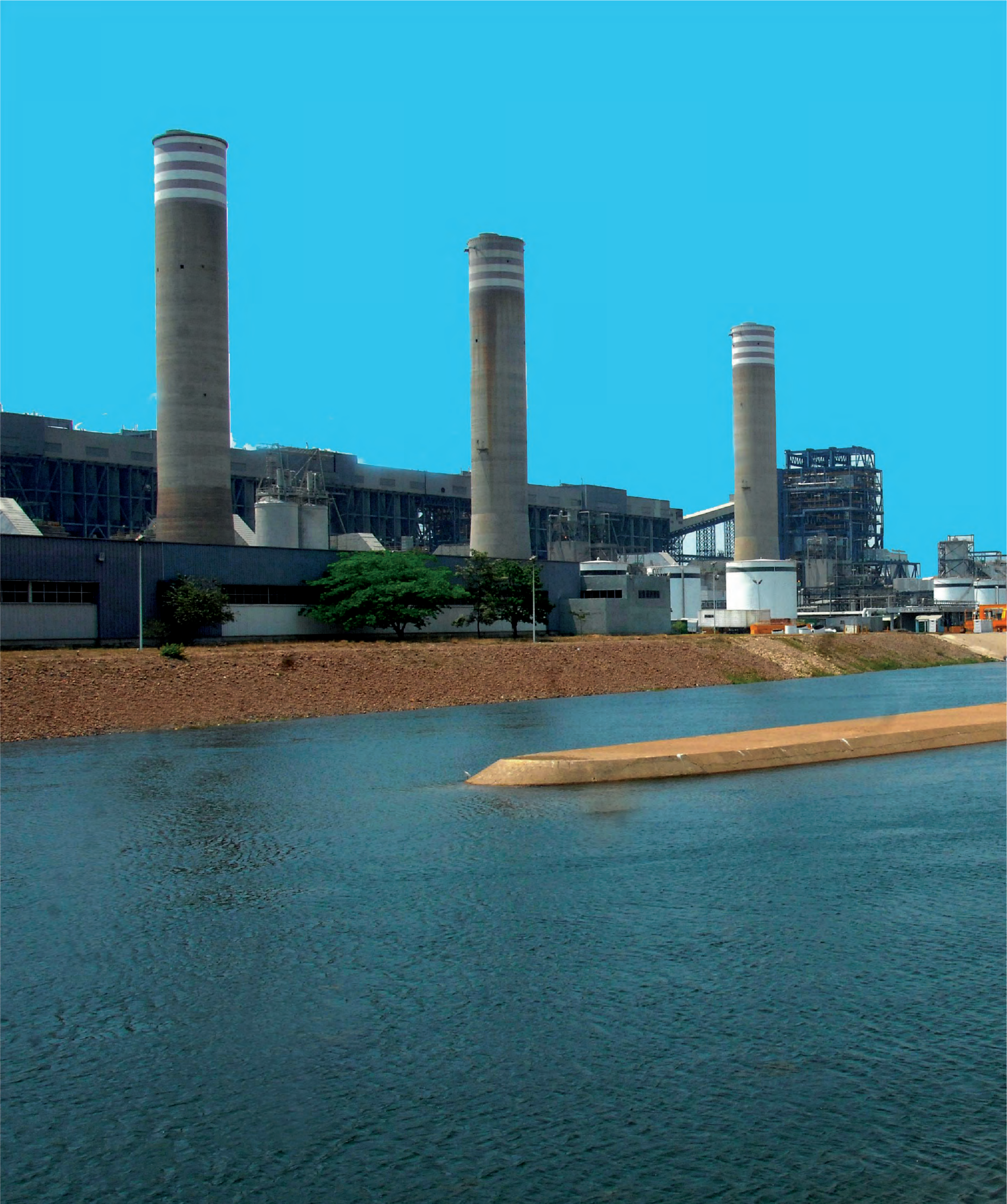
Fotografía 52. Central termoeléctrica. Guerrero. Comisión Federal de Electricidad.
