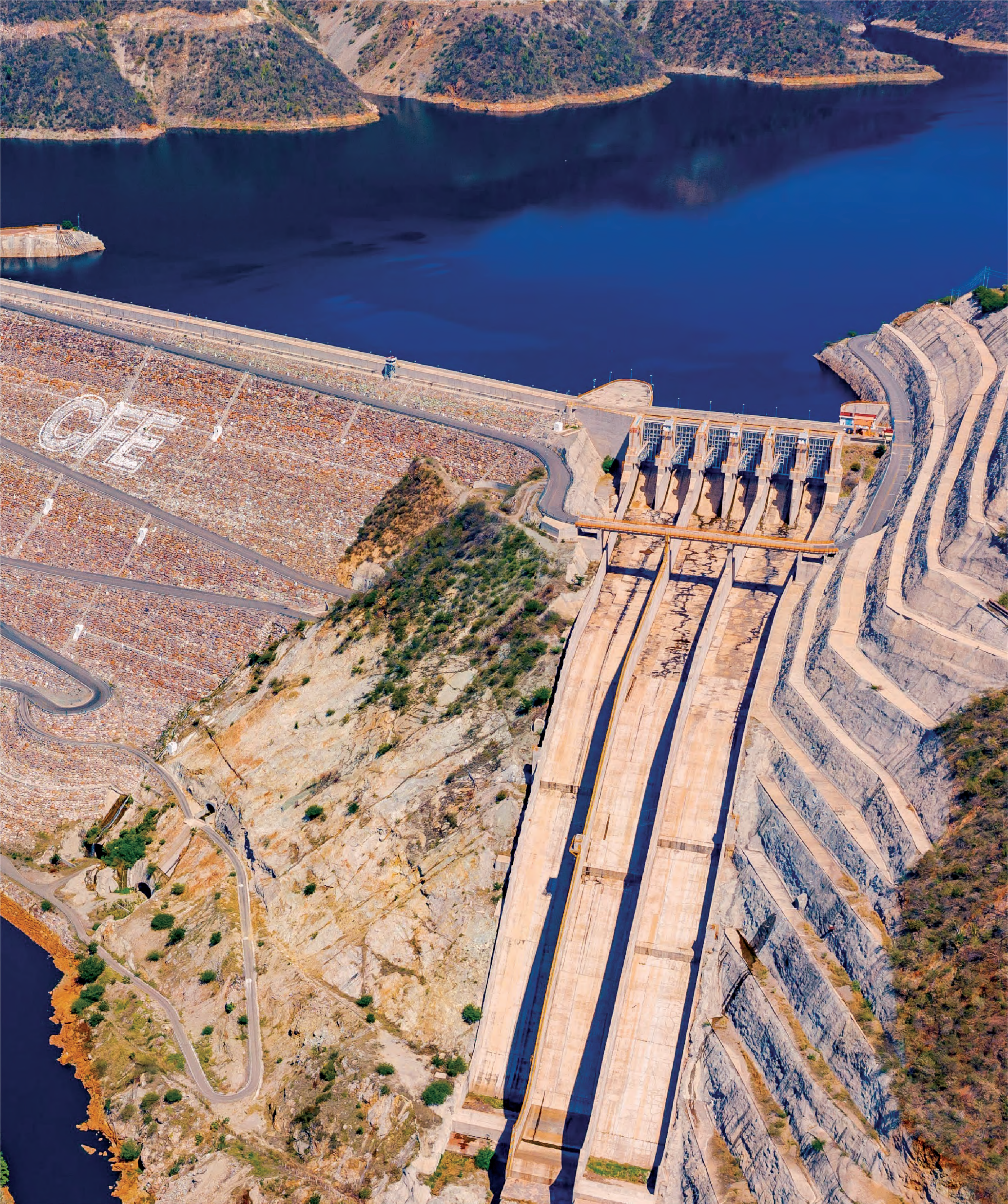
Fotografía 2. Hidroeléctrica "La Yesca", Nayarit. 2019. Comisión Federal de Electricidad.
