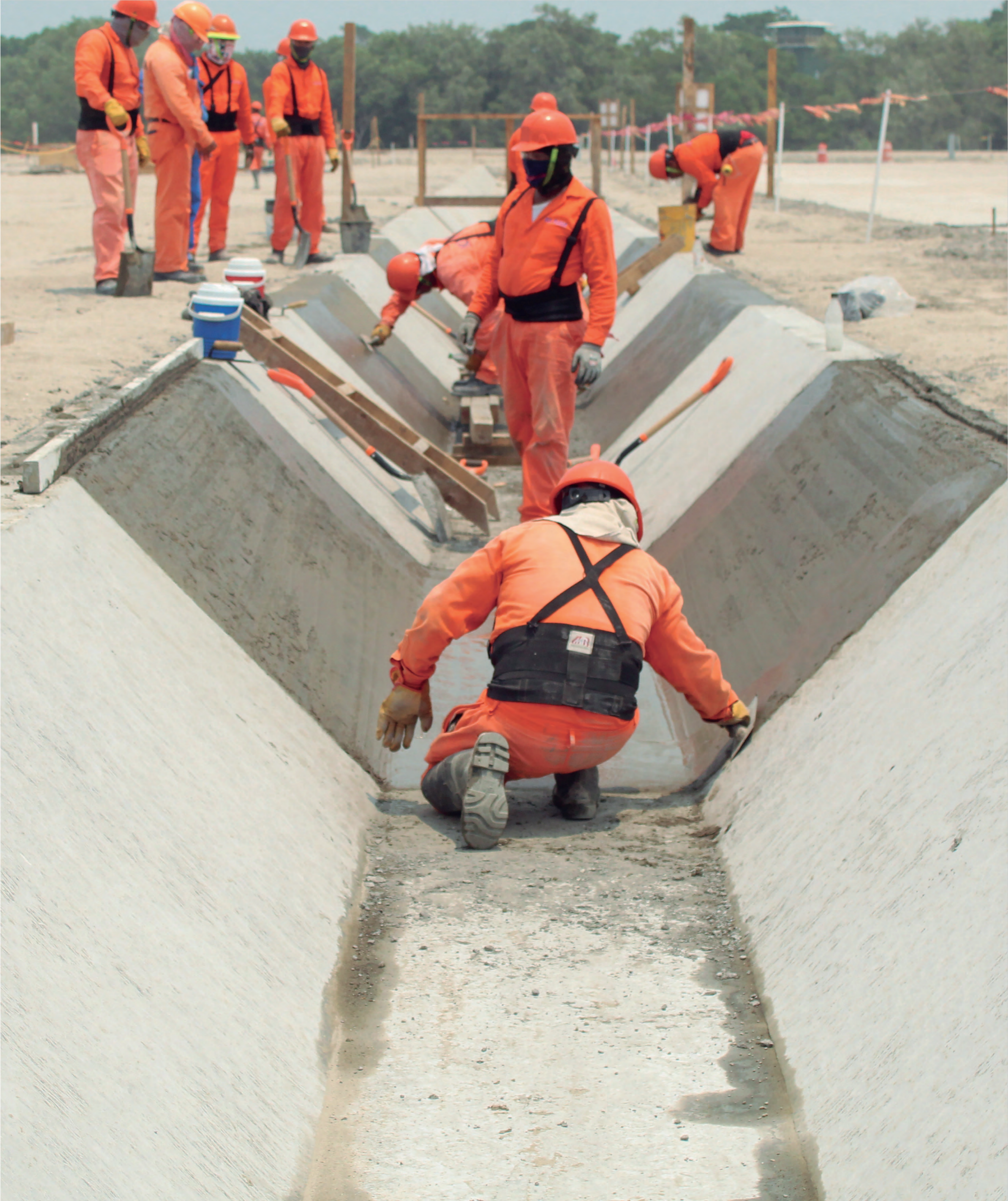
Fotografía 21. Avance de obra de la nueva refinería en Dos Bocas, Tabasco. 11 de abril de 2020. Secretaría de Energía.
