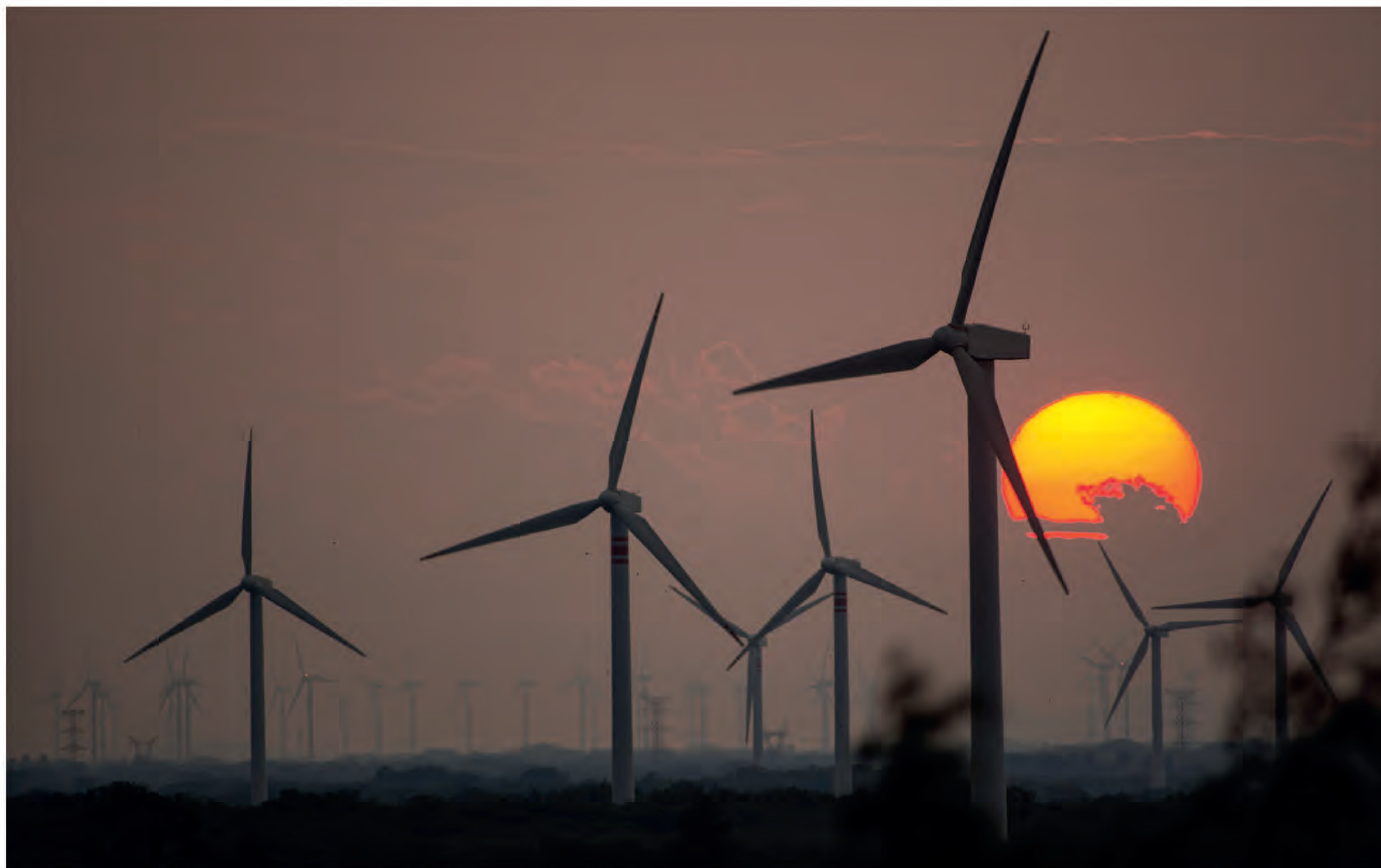
Fotografía 9. Complejo eólico Oaxaca, Istmo de Tehuantepec. Comisión Federal de Electricidad.
