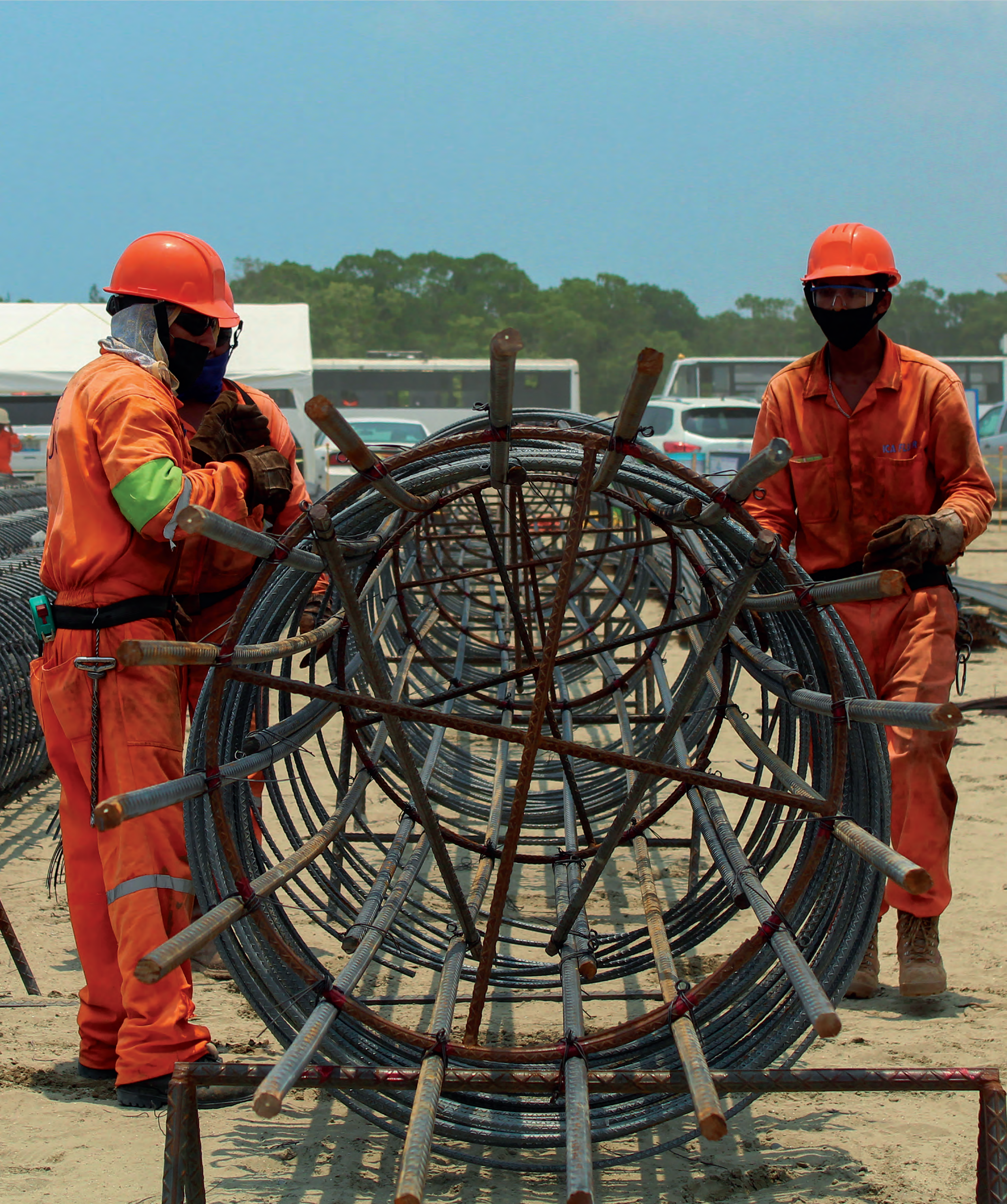
Fotografía 53. Trabajos de construcción en la nueva refinería en Dos Bocas, Paraíso, Tabasco. 13 de mayo de 2020. Secretaría de Energía.
