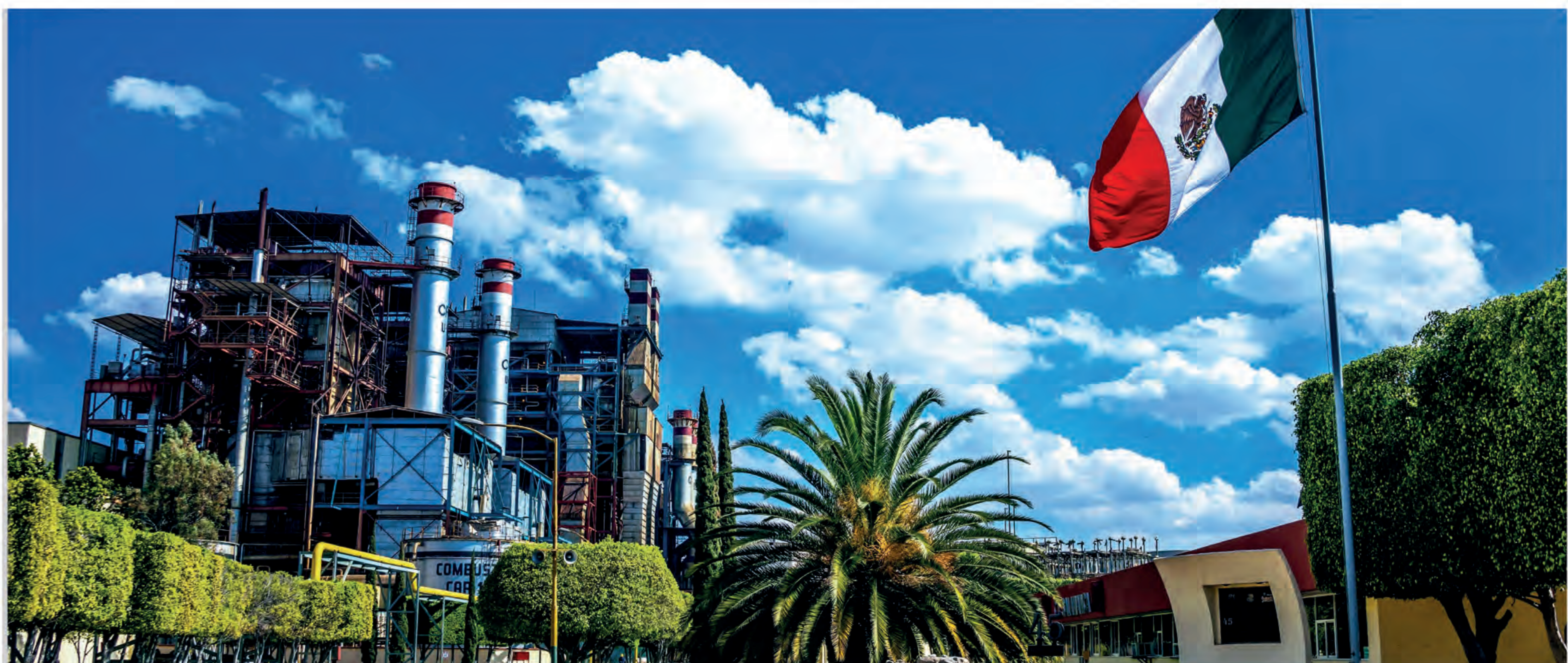
Fotografía 5. Central Termoelectrica "Salamanca" Comisión Federal de Electricidad.
