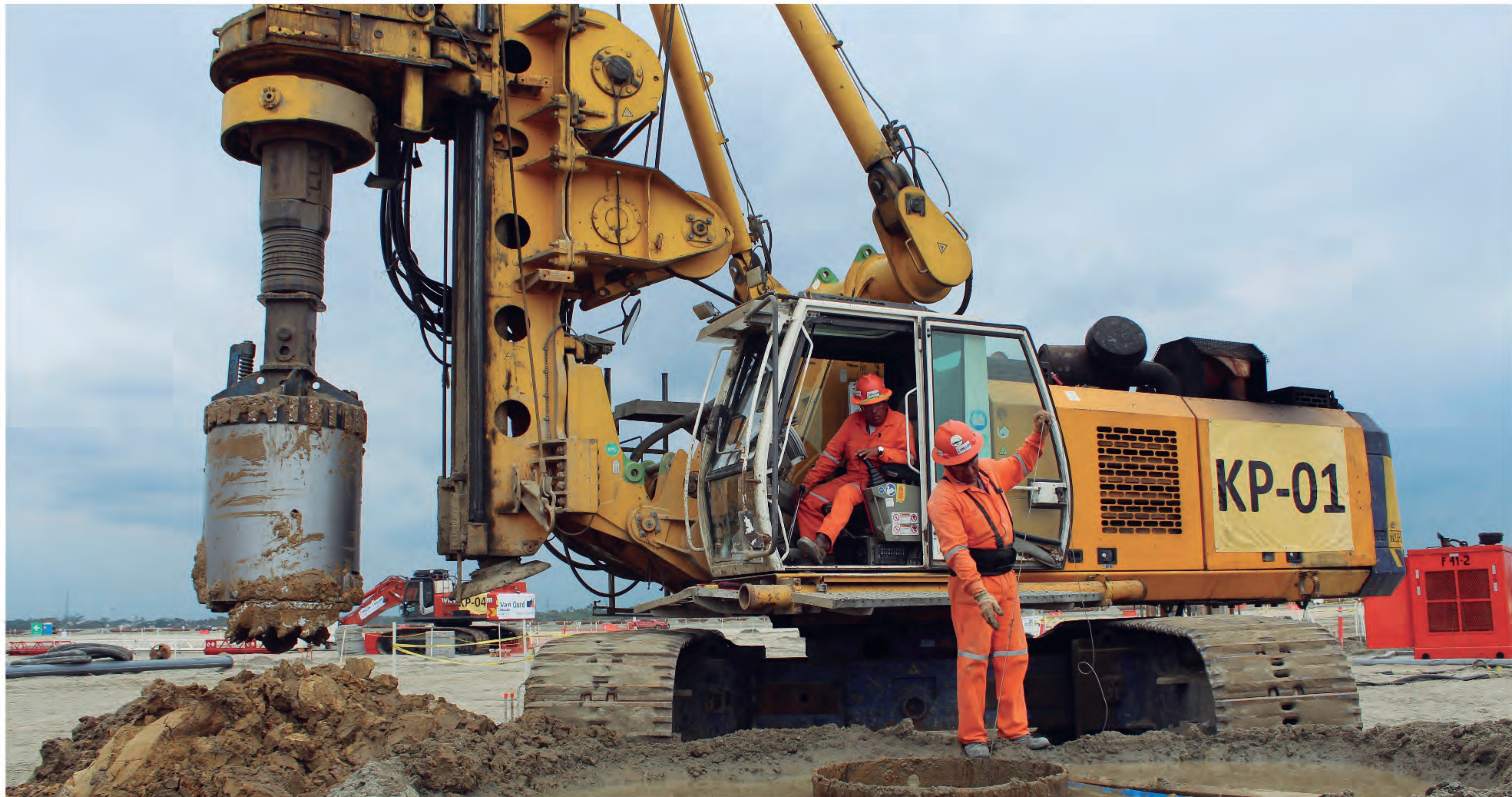
Fotografía 20. Trabajadores en la construcción de la nueva refinería en Dos Bocas, Tabasco. 24 de enero de 2020. Secretaría de Energía.
