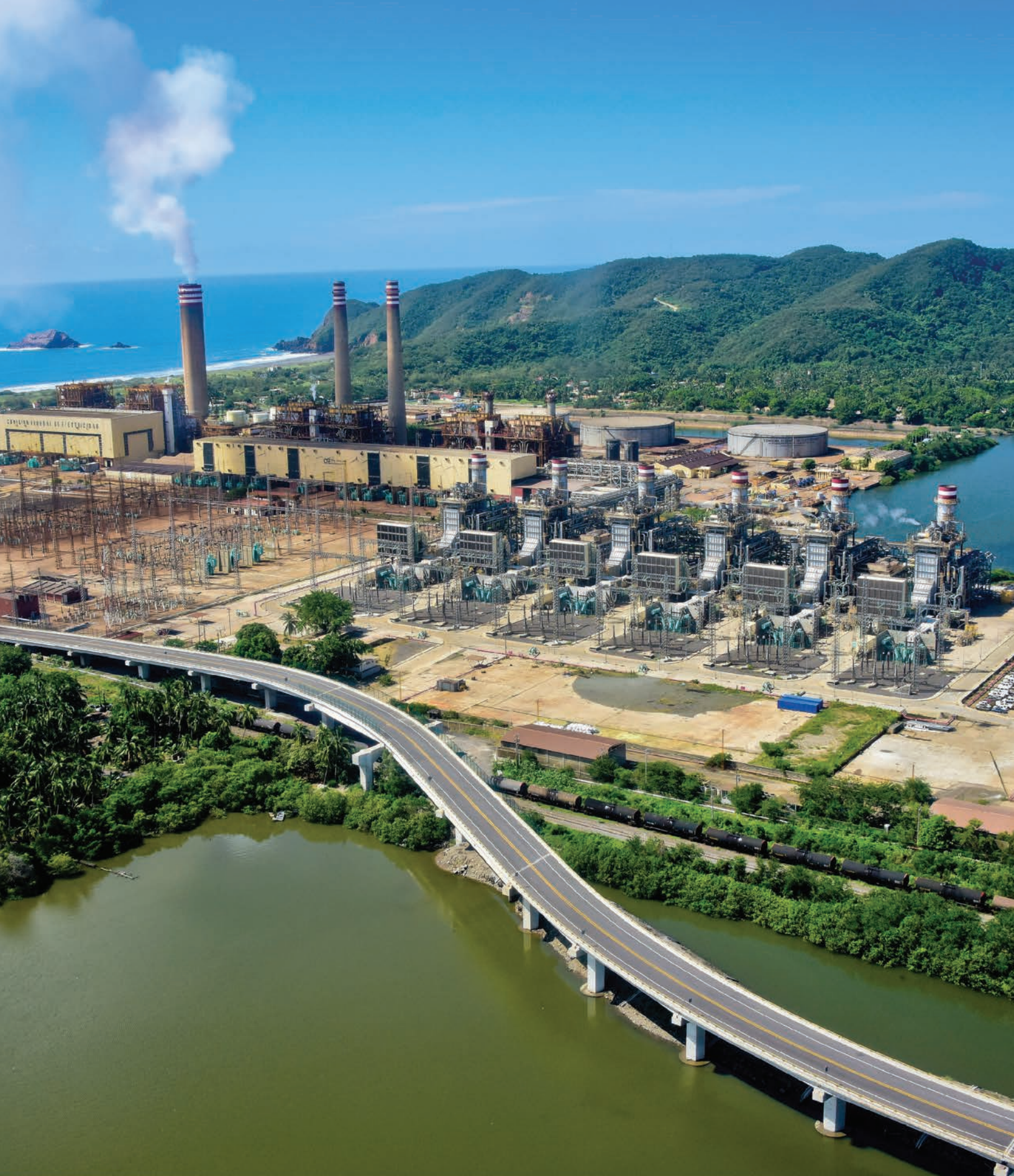
Central termoeléctrica, Manzanillo Colima. Comisión Federal de Electricidad.
