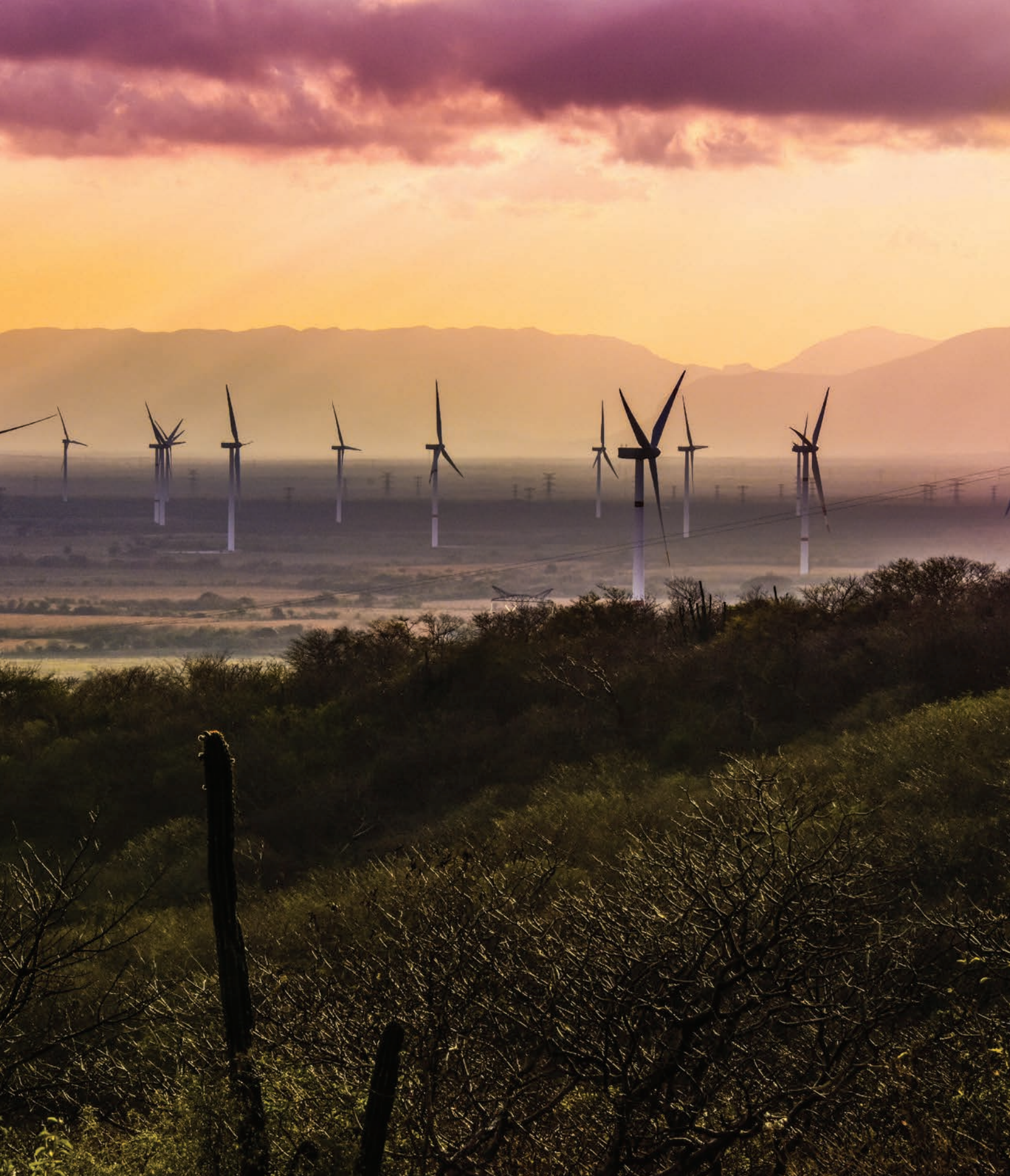
Central eoloeléctrica, Asunción Ixtaltepec, Oaxaca. Comisión Federal de Electricidad.
