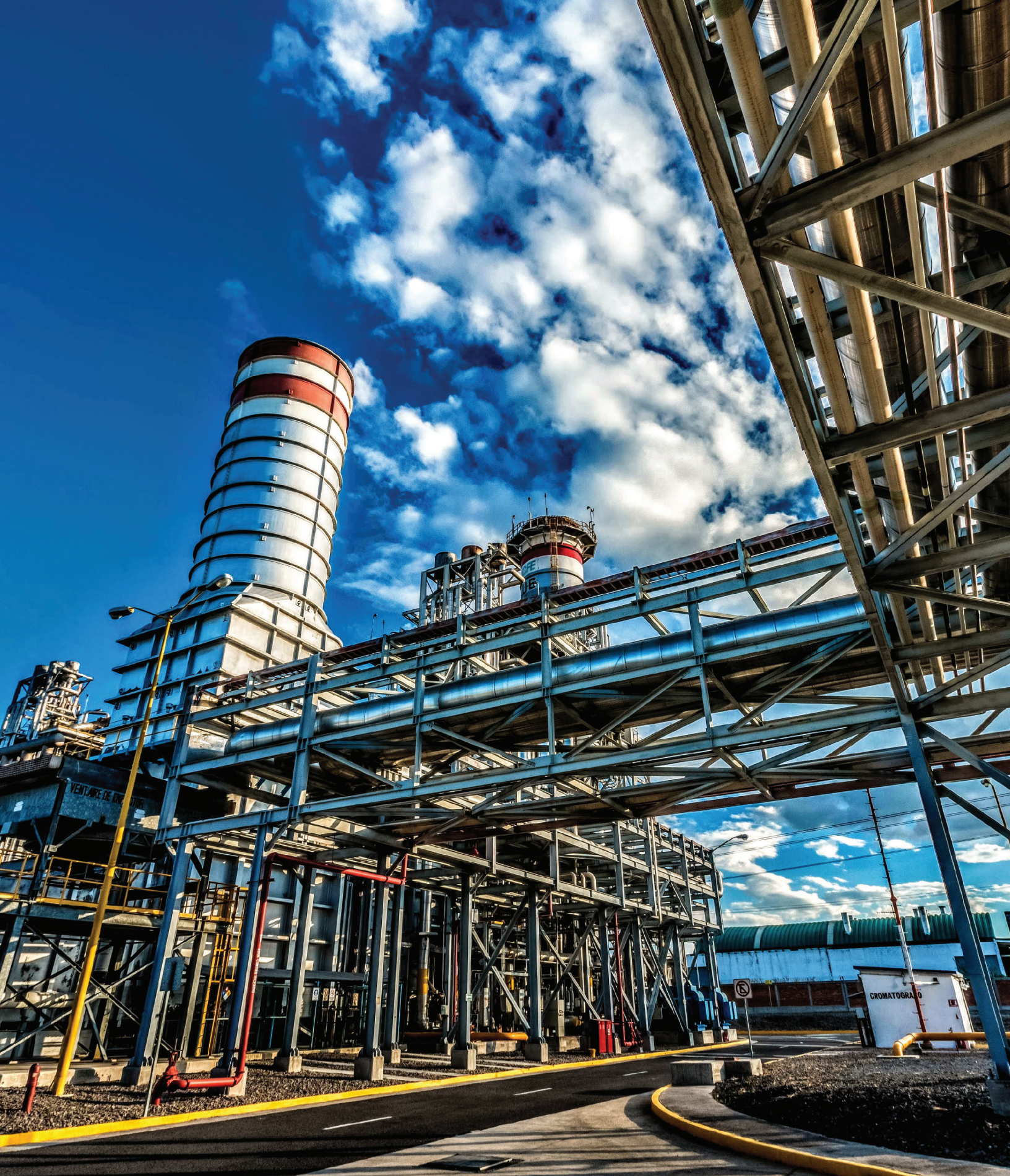
Central termoeléctrica, Santiago de Querétaro, Querétaro. Comisión Federal de Electricidad.
