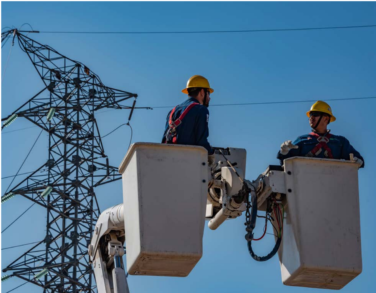
Maniobras en torre eléctrica. Sonora. Comisión Federal de Electricidad.
