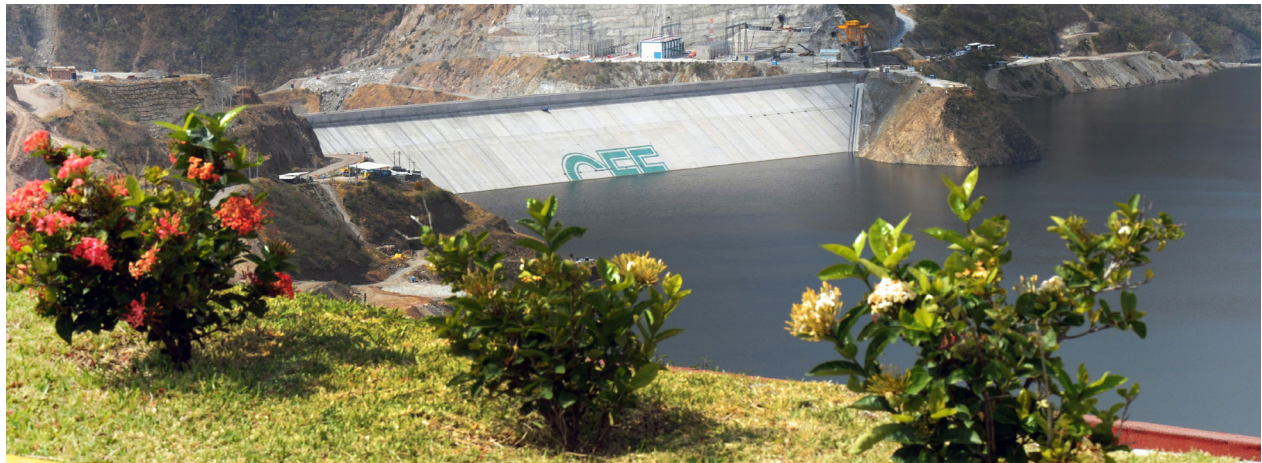
Central hidroeléctrica. La Yesca, Nayarit. Comisión Federal de Electricidad.
