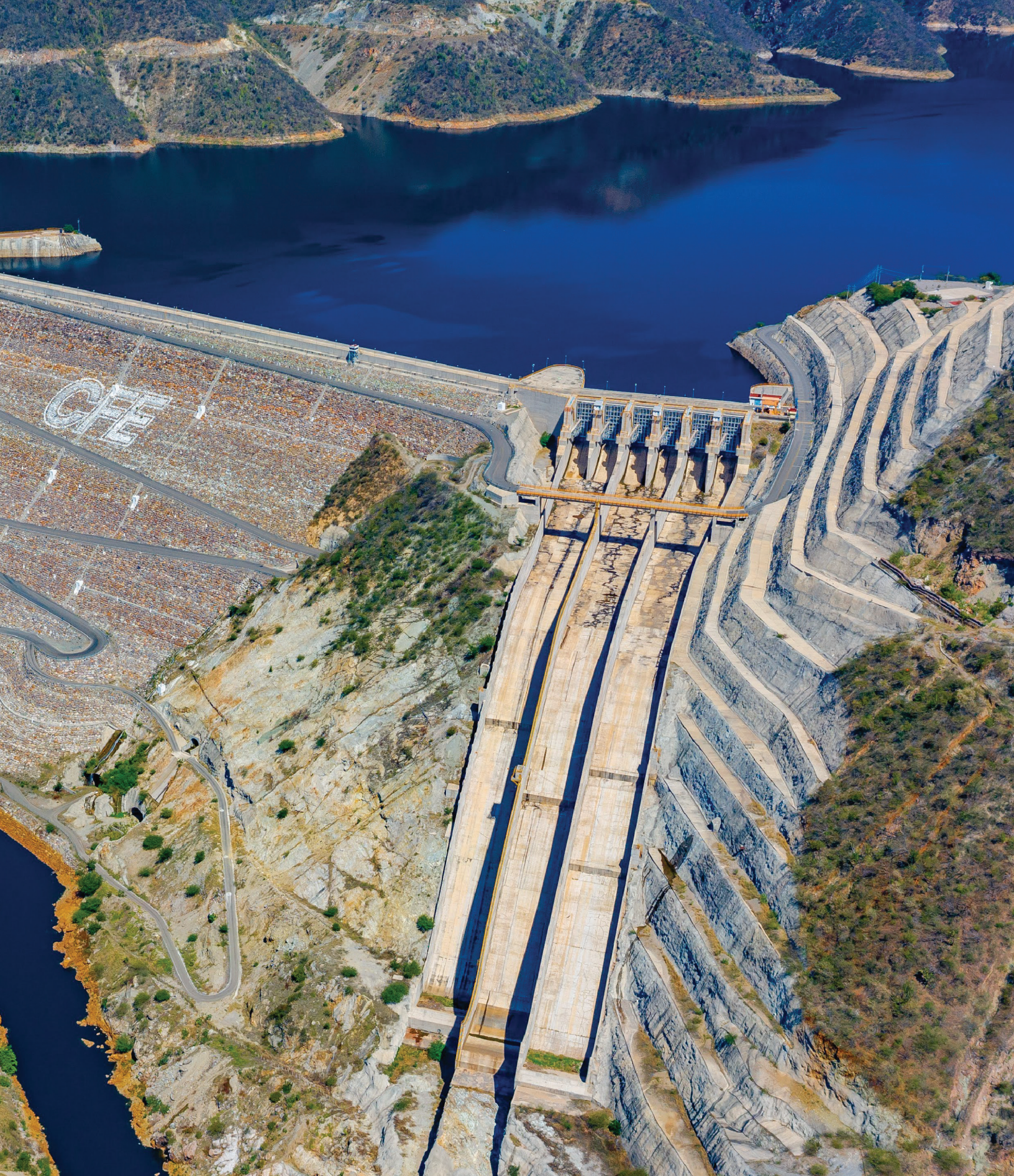
Central hidroeléctrica, La Yesca, Nayarit. Comisión Federal de Electricidad.
